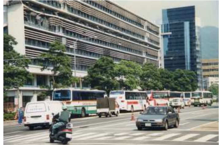
市役所2号館 (中央区)
