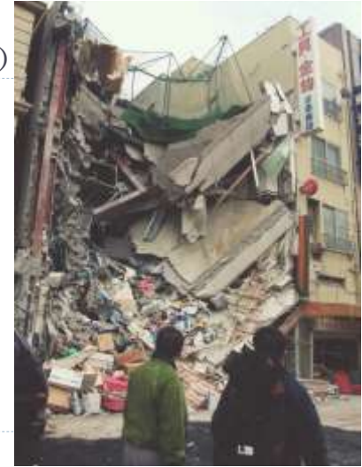
被災状況 (中央区)
