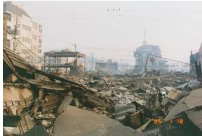
被災状況（須磨区）
