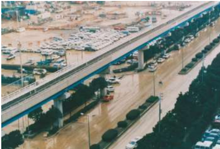
ポートアイランド液状化 (中央区)
