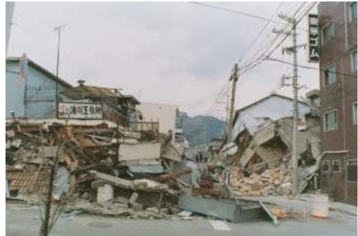
被災状況 (東灘区)
