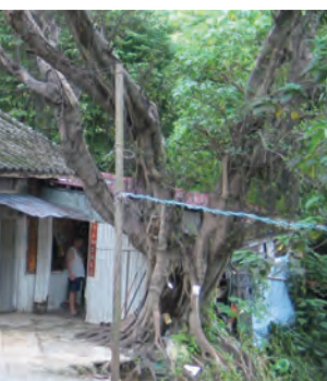
十坪住宅「双愛舎」
