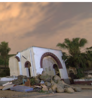
解体中の旧事務本館(2009年)
